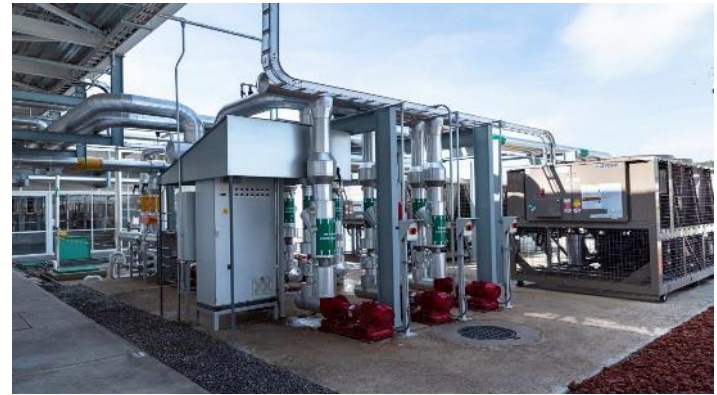
Sistema de enfriamiento de agua para planta OTC
