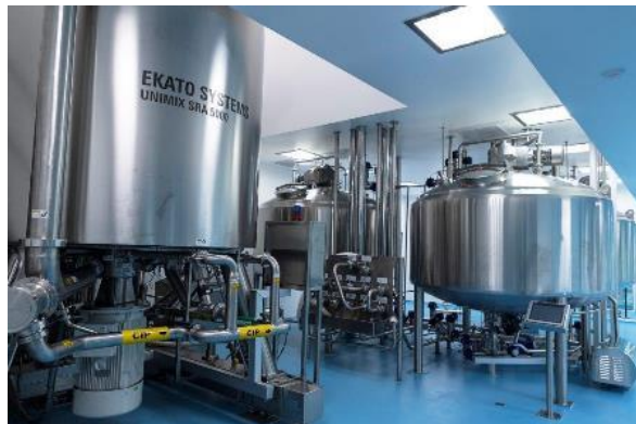
Sistema de tanques para producción de líquidos de la planta OTC
